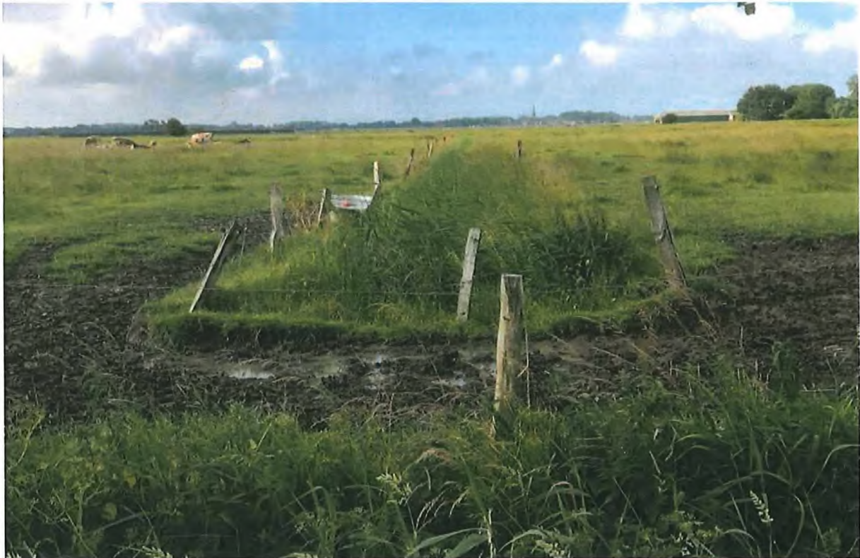
Abbildung 9: Entwässerungsgraben auf dem Flurstück 68, der mit Solarmodulen überbaut werden soll (Foto: Elbberg Juni 2022).
