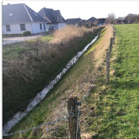
Abbildung 9: Verbandsvorfluter 0103 im Süden des Plangebiets (23.02.2022)
