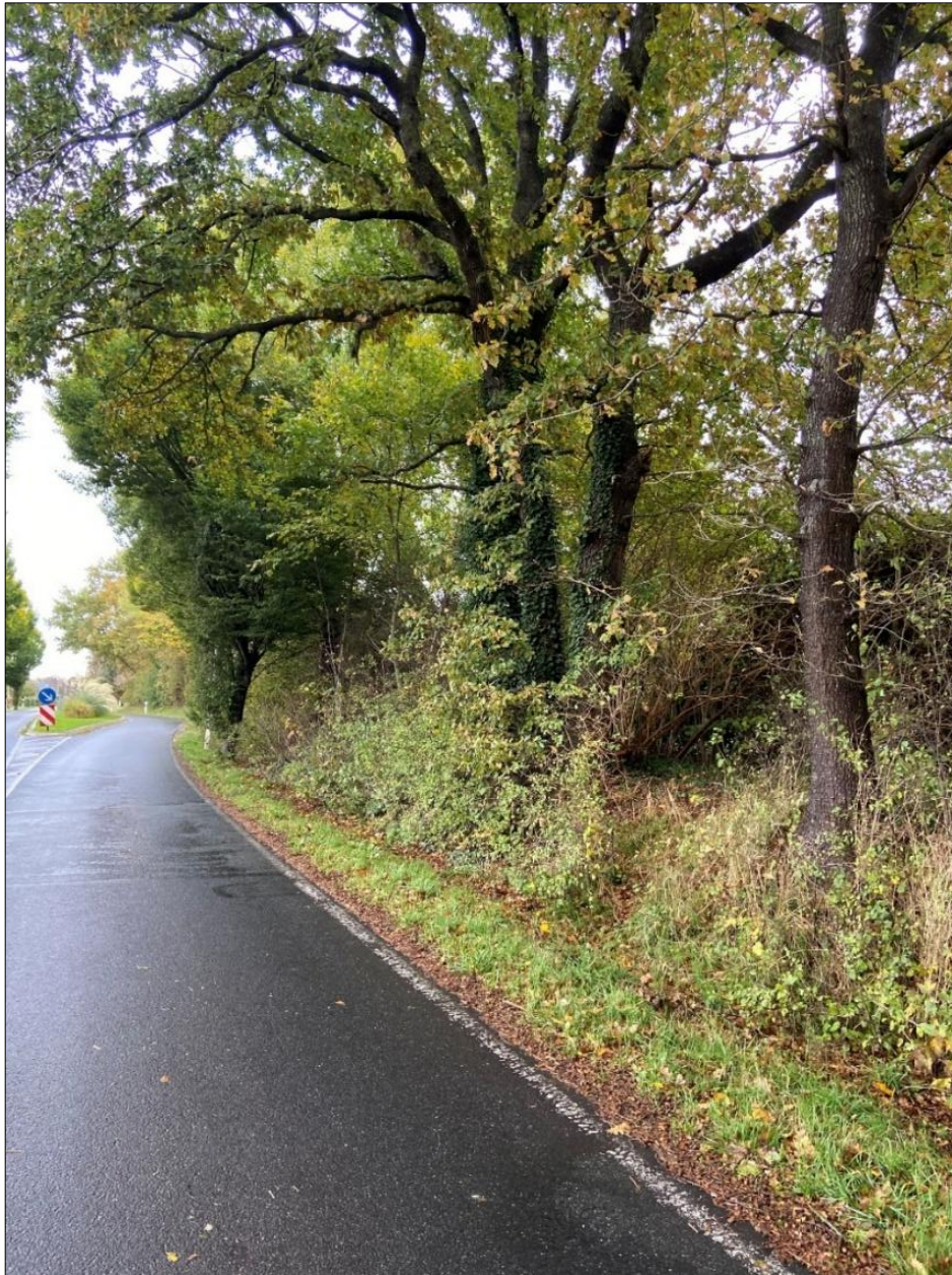
Abbildung 6: Knick auf der gegenüberliegenden Straßenseite der L 236 (Aufnahme Oktober 2025)
