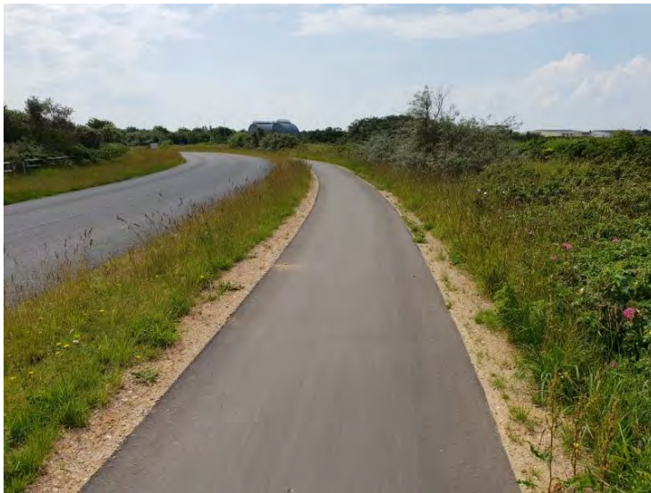
Hafenstraße, Blick nach Süden, im Hintergrund der „Wattwurm“
